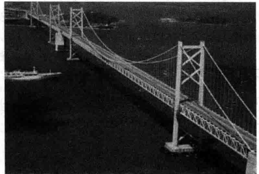
图 1.2 日本南、北备赞濑户大桥
