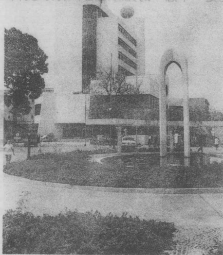
长沙电冰箱厂的科技办公楼。
