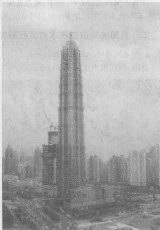
上海金茂大厦(1999 年)
