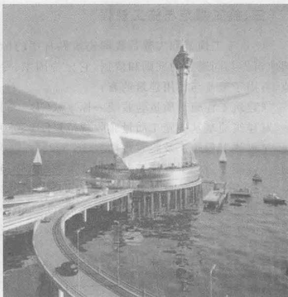
杭州湾大桥(2007年)
