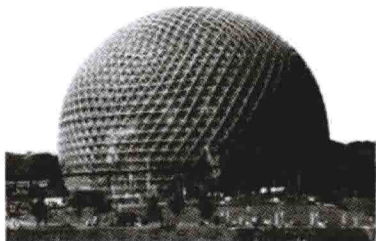
图 1.1.9 蒙特利尔短程线型双层网壳 ( D=76\text{m} )
