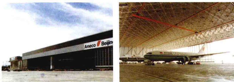
图 1.1.13 首都机场四机位机库网架
