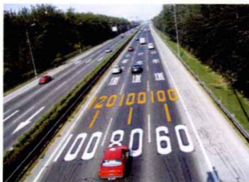
● 图2-12 高速公路限速标志
