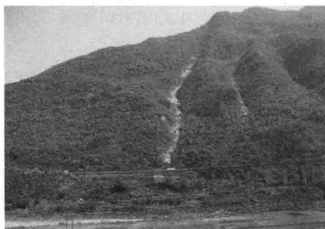
图 13 宝成铁路金龟岩大桥右侧 200m 高处陡岩坍塌
