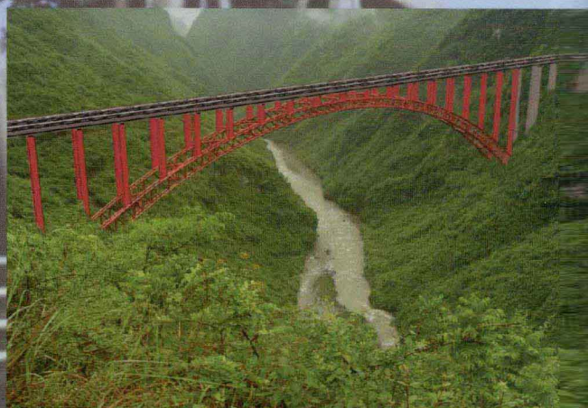
● 桥梁公司设计的支井河特大桥（上承式钢管混凝土拱桥，跨度430米，两相对高差755米）
