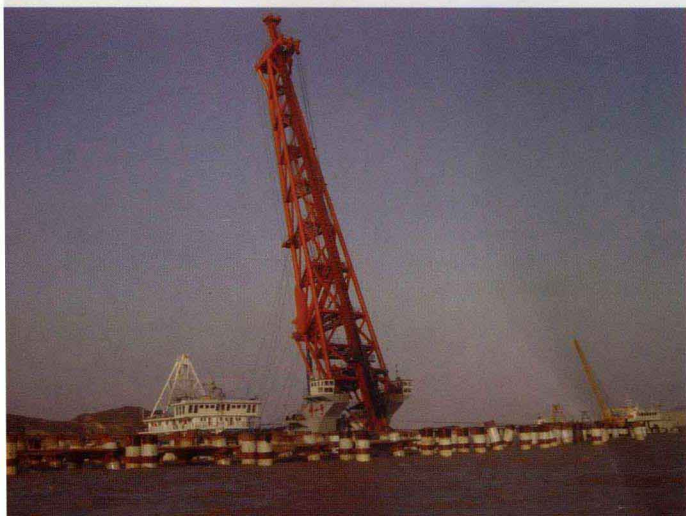
自行研制目前高度为国内之最新的打桩机用于洋山深水港码头打桩。
