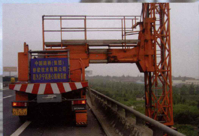
桥梁公司在沪宁高速进行公路桥梁检测现场
