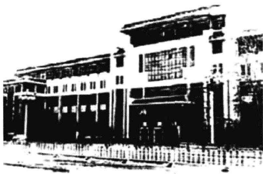
图 1-4 原纺织工业部办公楼增层改造
