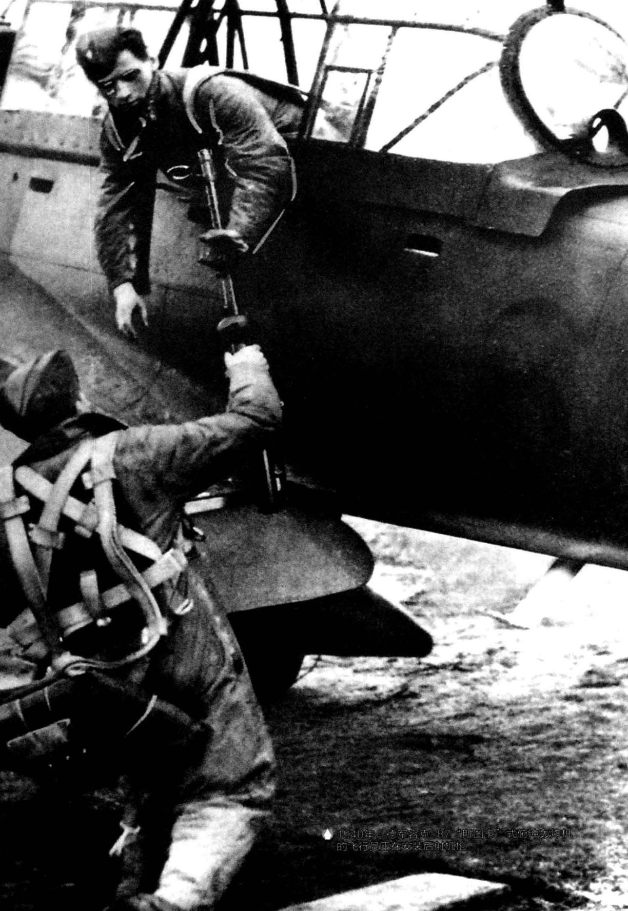
1940年，德军容克-87“斯图卡”式俯冲轰炸机的飞行员正在安装后射机枪
