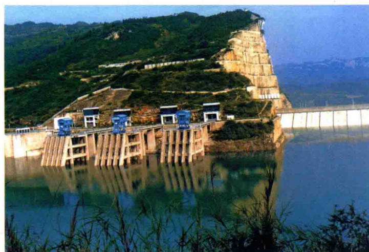
洪家渡水电站
