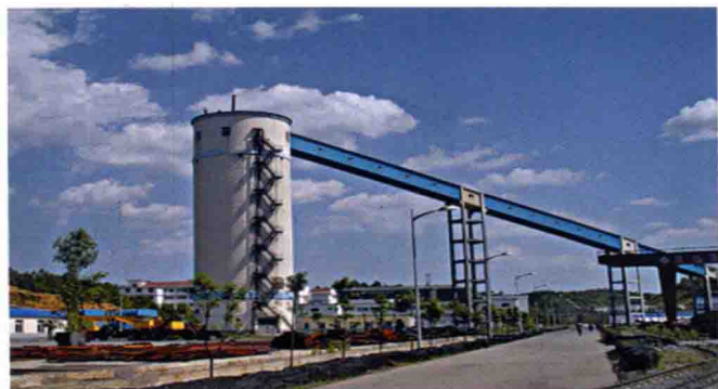
青龙煤矿运输系统皮带栈桥
