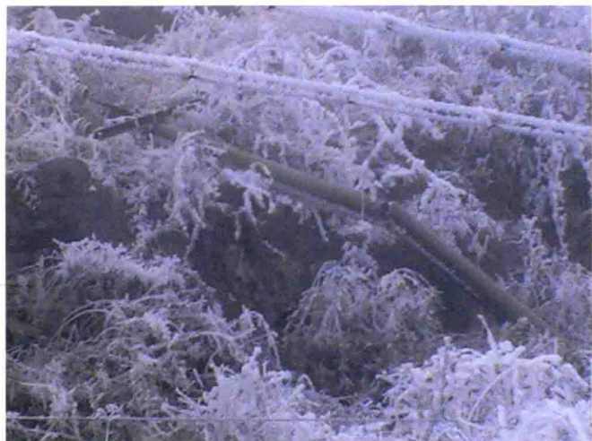
雪凝损毁的电杆
