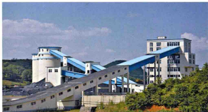
青龙煤矿原煤生产系统
