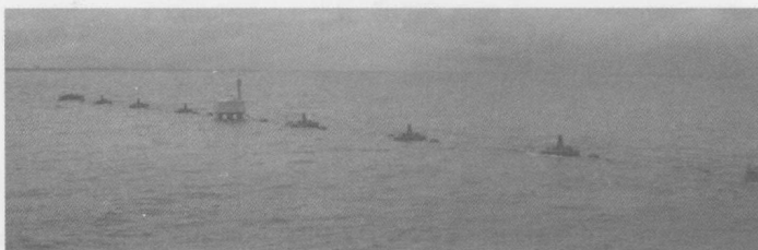
图 1-4 浙江杭州湾跨海大桥浮筒链条拦船装置
