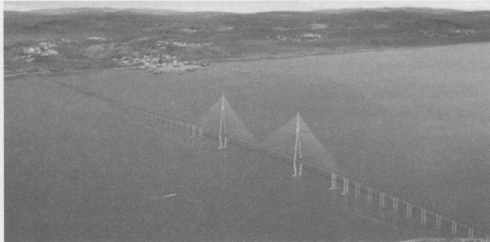
图 1-5 浙江象山港大桥主桥及两侧共 10 个桥墩柔性防船撞装置
