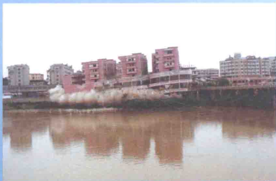
江西省拆除侵占河道建筑
