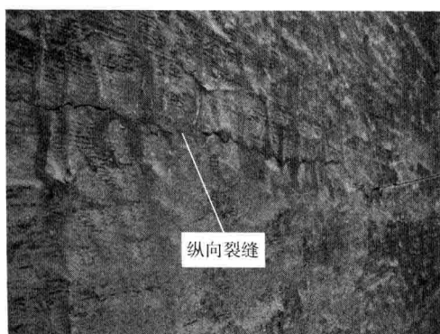
图 1-7 板底面的纵向裂缝
