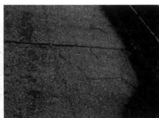
图 1-11 梁端沿预应力方向裂缝
