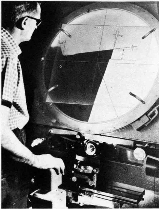
Fig. 1 光学的比較測定器と測定機械を用いたバイトの検査 (Jones and Lamson Machine Co.)
