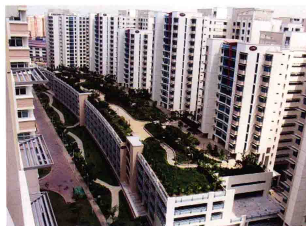
图 1-5 新加坡屋顶花园（Punggol 屋顶花园）
