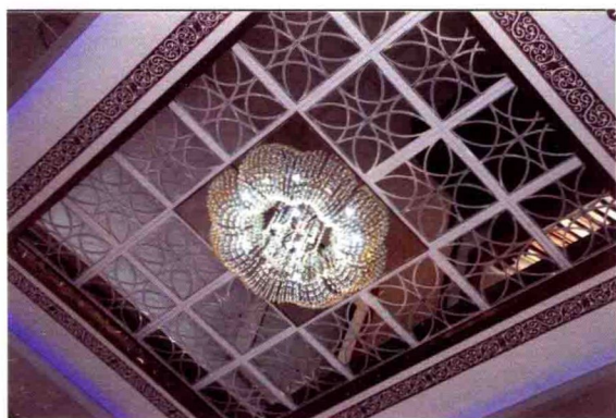
图1-3 玻璃造型吊顶
