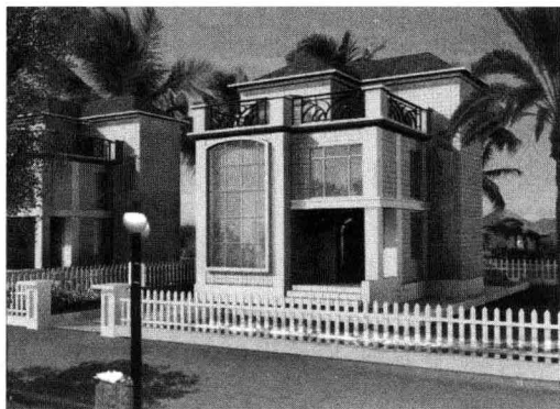
(b) 居住建筑(某住宅小区)
