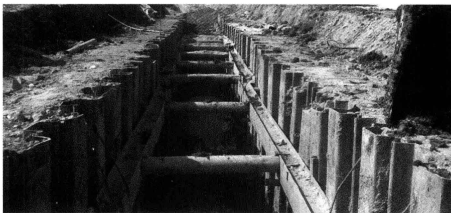
图 1-8 拉森钢板桩支护
