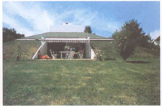
彩图 7-12(a) 法国某掩土建筑住宅 C. P. 7-12(a) An earth sheltered dwelling in France
