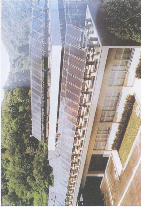
彩图 5-3 日本的安装在屋顶的大面积太阳能热水器
