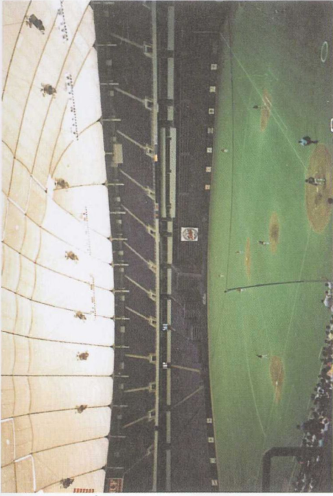
彩图 5-18 美国的大跨充气薄膜自然采光屋顶
