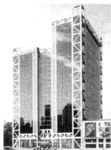
(a) 国内首个应用自主研发的屈曲约束支撑结构
