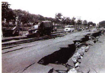
构造地震裂缝
