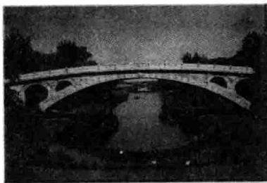
赵州桥(公元 591—605 年)又称安济桥,位于中国河北省赵县城南,是现存最早,并且保存良好的拱桥。单孔空腹圆石拱桥,长 64.4m,净跨 37.20m,矢高 7.23m。主拱圈上两侧各开两个小拱,以宣泄洪水,减轻自重。该桥制作精良,结构独创,造型匀称美丽,雕刻细致生动,历代都予重视和保护,1991 年列为世界文化遗产。
