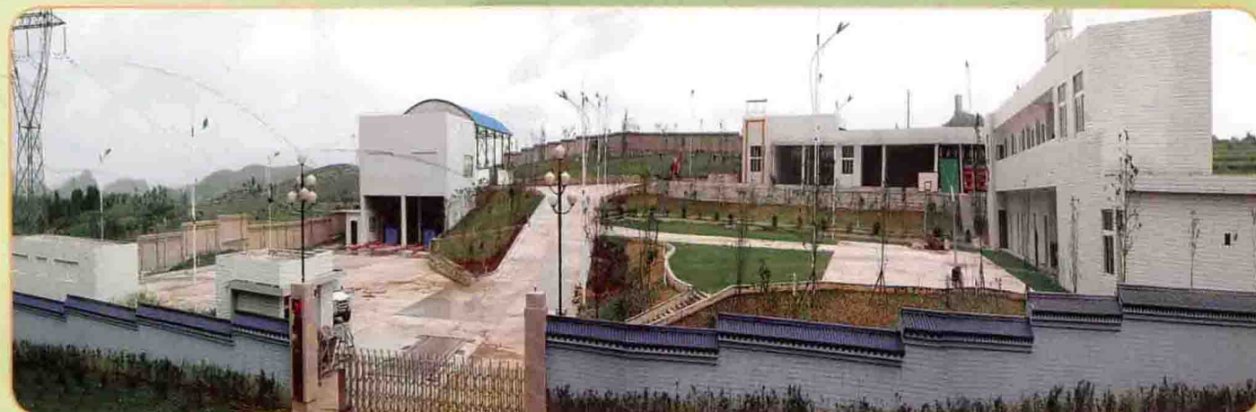
建设环卫设施改善市容市貌——图为青山垃圾转运站
