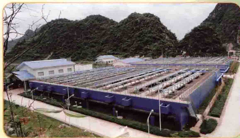
落实减排措施保住青山绿水——图为刚建成的市污水处理厂
