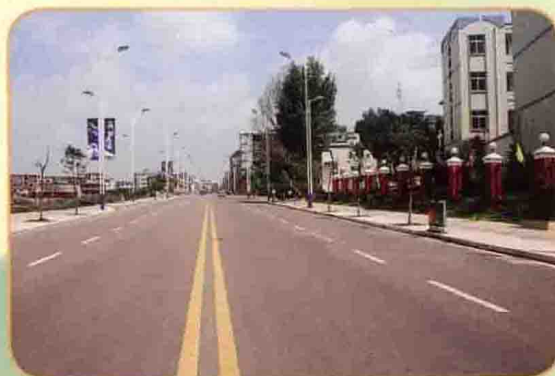
大力实施市政建设加快城镇化进程——图为市中心城区新建道路
