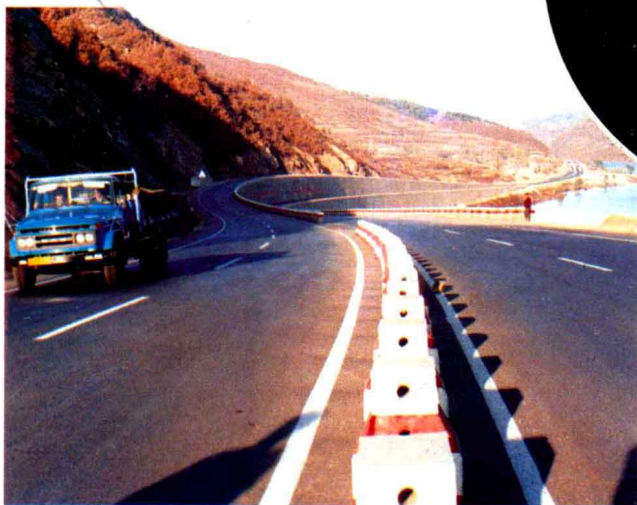
该局施工的四浑公路
