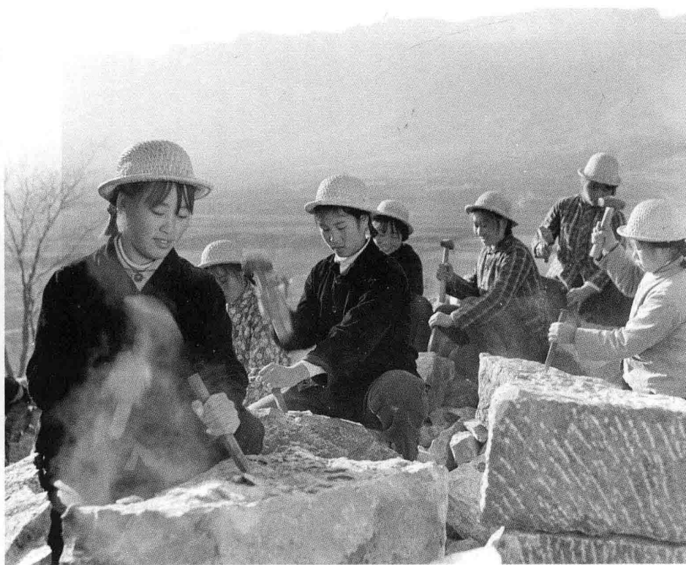
河南省林县红旗渠建设工地上的女石匠
