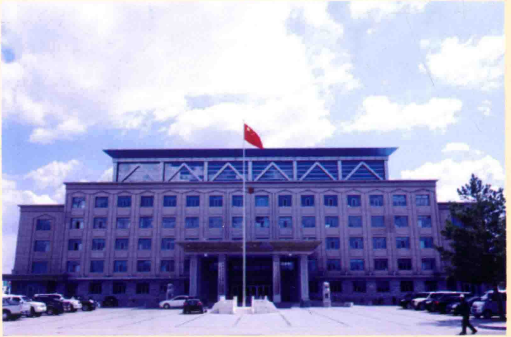
鄂温克族自治旗政府大楼
