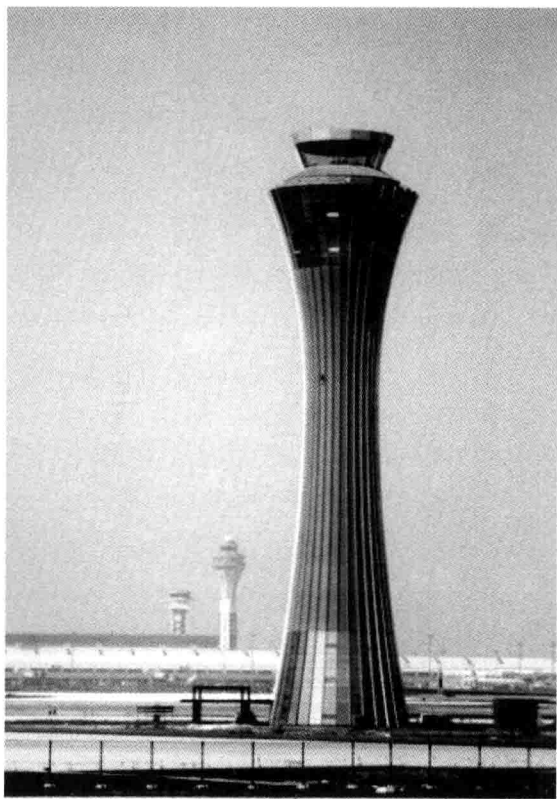
图 5 北京首都国际机场管制塔台
