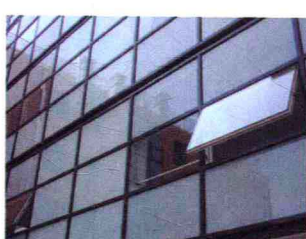
镀膜玻璃在建筑外墙的应用
