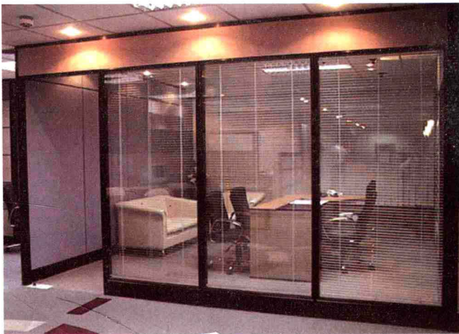
c 室内玻璃隔断
