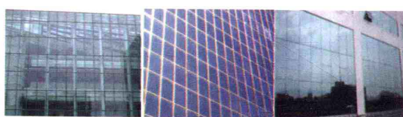
明框式玻璃幕墙 半隐式玻璃幕墙 全隐式玻璃幕墙 玻璃幕墙
