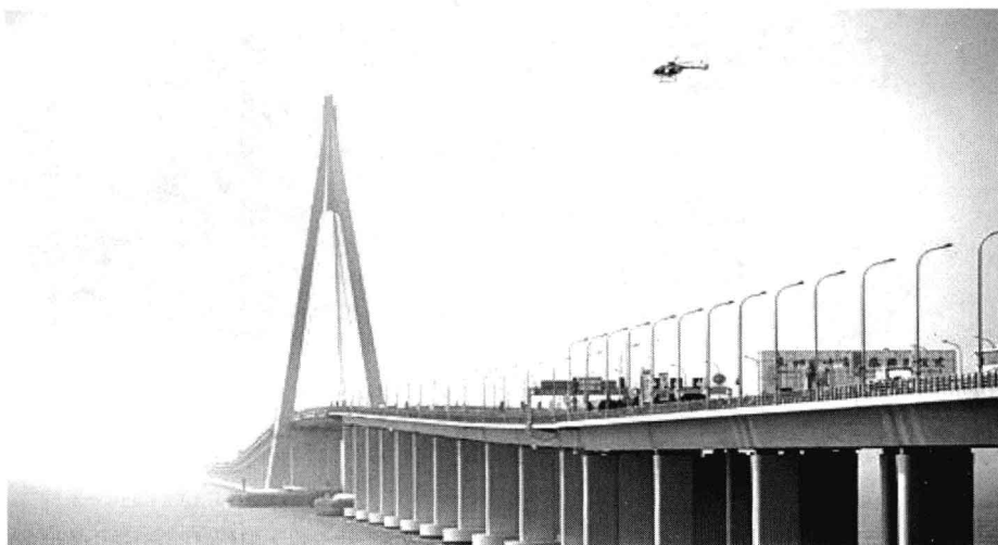
图绪-2 杭州湾跨海大桥
