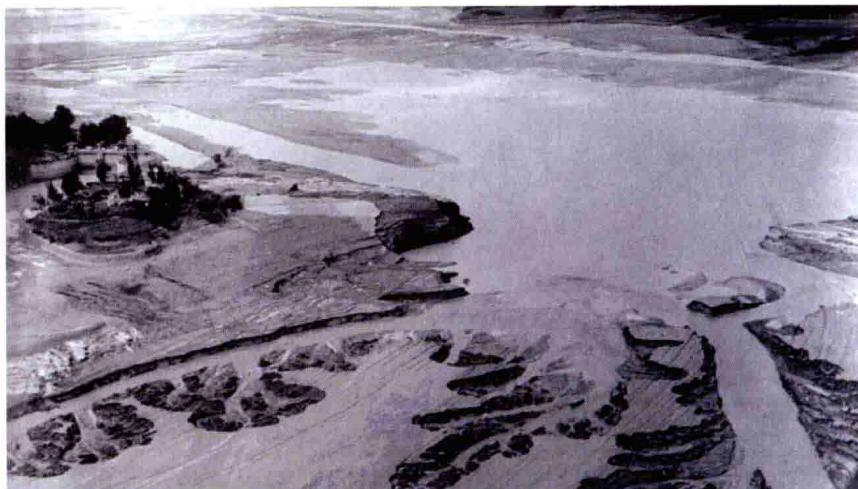
图 1.2 石漫滩水库均质土坝溃决
