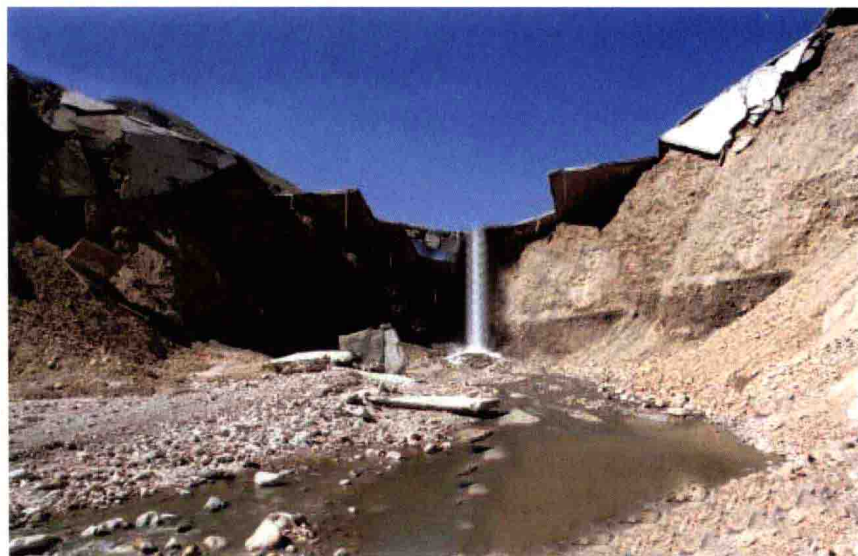
图 1.3 沟后水库面板砂砾坝溃决
