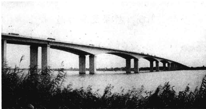
图 1.11 南京长江二桥北汊桥
