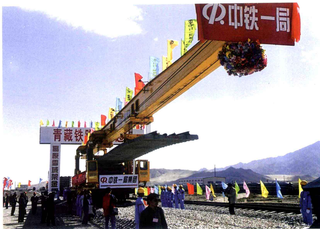
青藏铁路格拉段铺下第一节轨排
