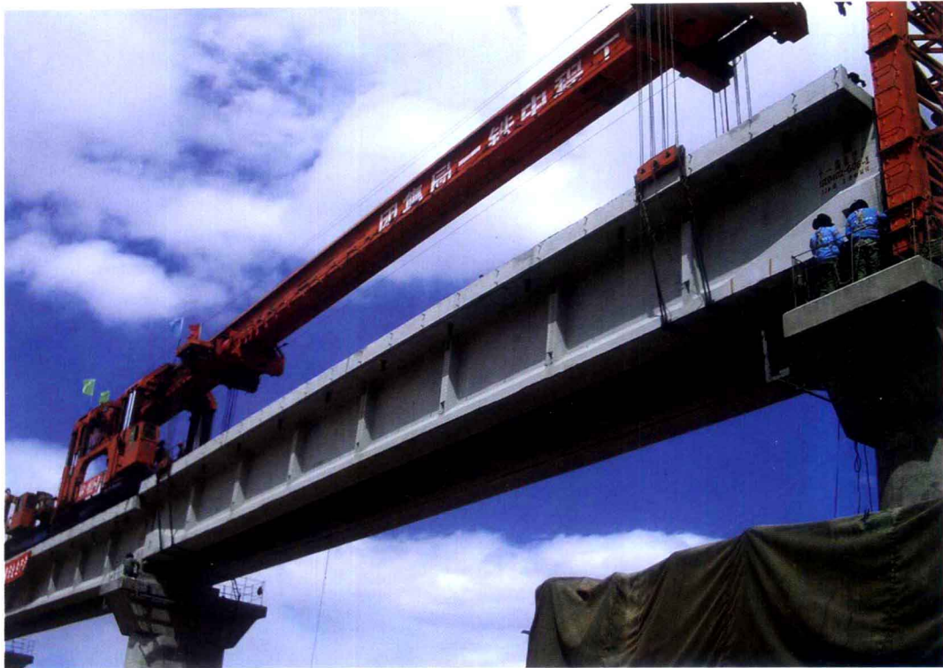
高原架梁施工
