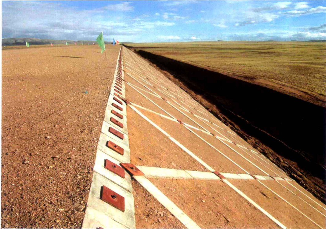
路堤护坡工程
