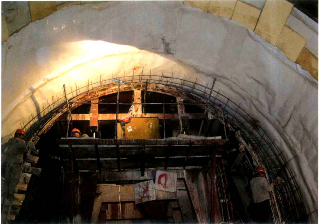
高原冻土区隧道施工
