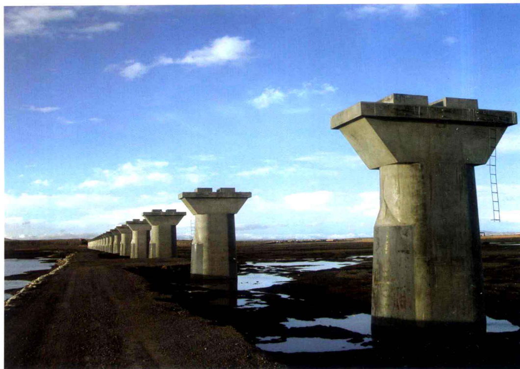
建设中的长江源特大桥
