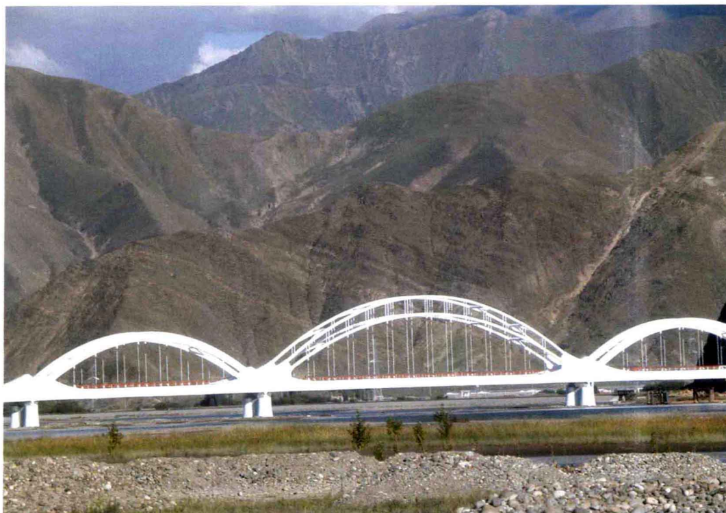
拉萨河特大桥
