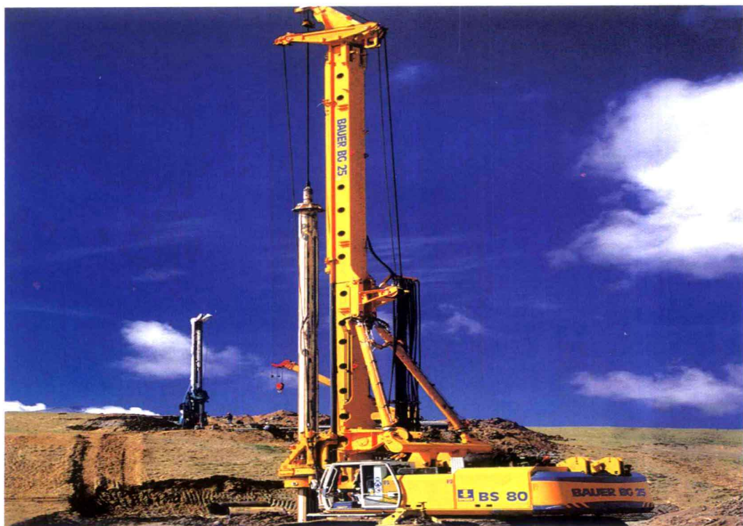
桥梁桩基旋挖钻干法成孔施工
