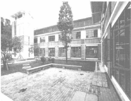
图 1-2 汶川灾后新建的木结构学校
