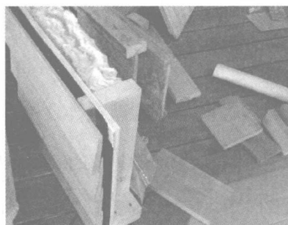
图 1-8 外墙结构
