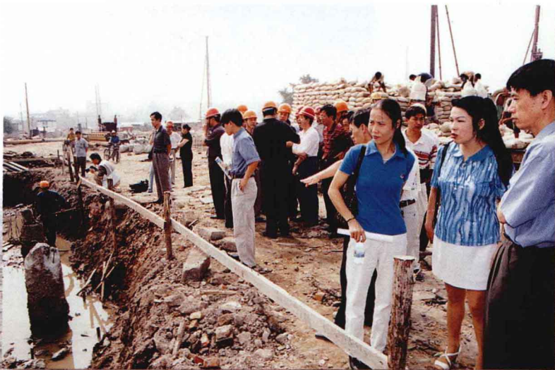
苍霞新区工地一角
