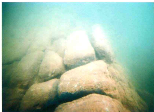
抚仙湖水下石质建筑物顶部（局部）
