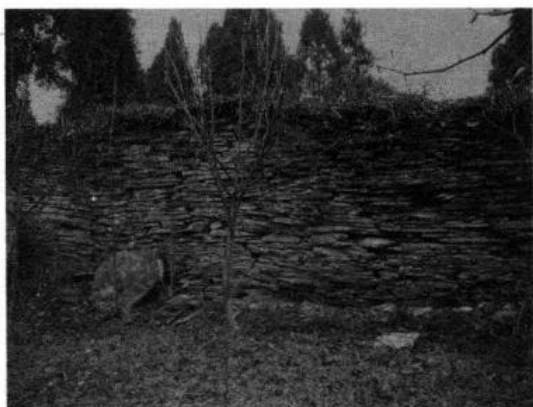
图1-2 新寨苗王城“城墙”遗址之一
