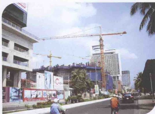
芽庄滨海大道上正在建设的高楼
