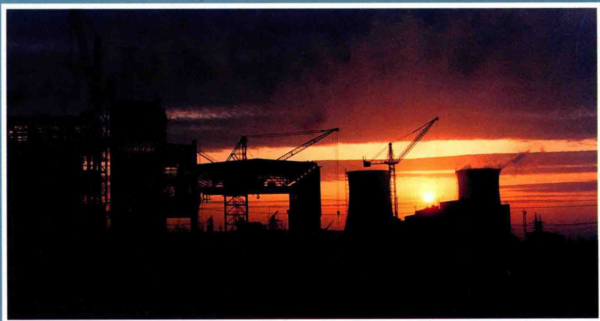
建設中的熱電廠
