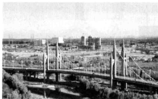
图 1-2 京昌平南环大桥(自锚式悬索桥)
