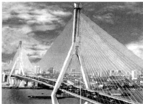
图 1-3 上海杨浦大桥
