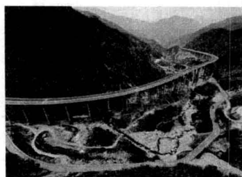
(c) 四川雅西高速公路干海子特 大桥(世界上最长的全钢管混 凝土桁架梁公路桥) 2012 年
