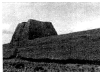
(c) 甘肃嘉峪关土筑长城（版筑结构）
