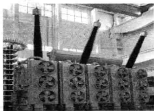
图 1-4 330kV 变压器
