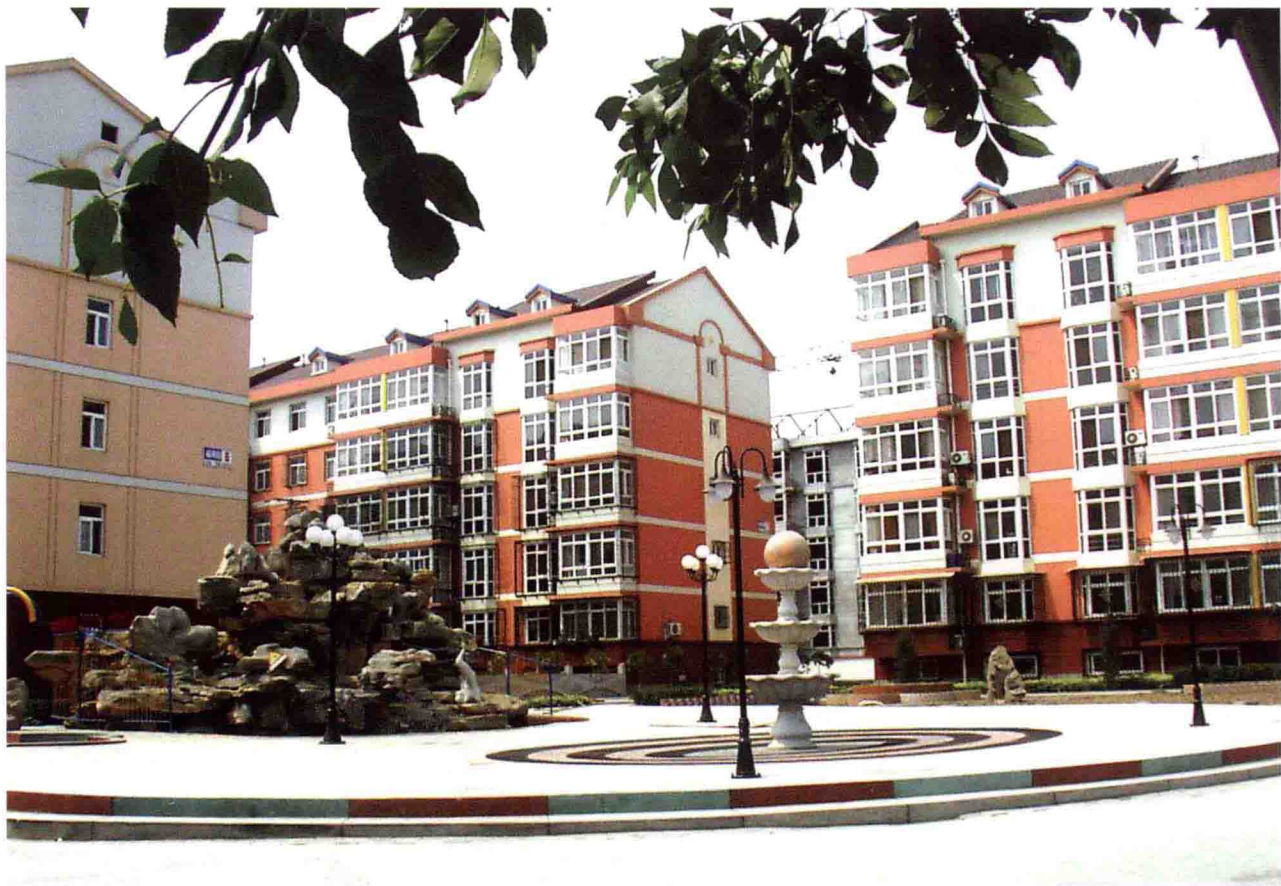
葛沽镇福海园住宅小区
