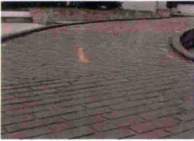
(45) 混凝土预制块路面
