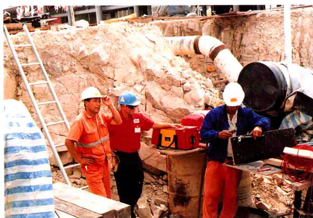
《香港新机场工地》
