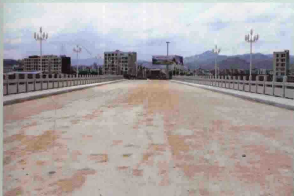
8月，投资750万元建设的白云大桥全面竣工（县志办供）
