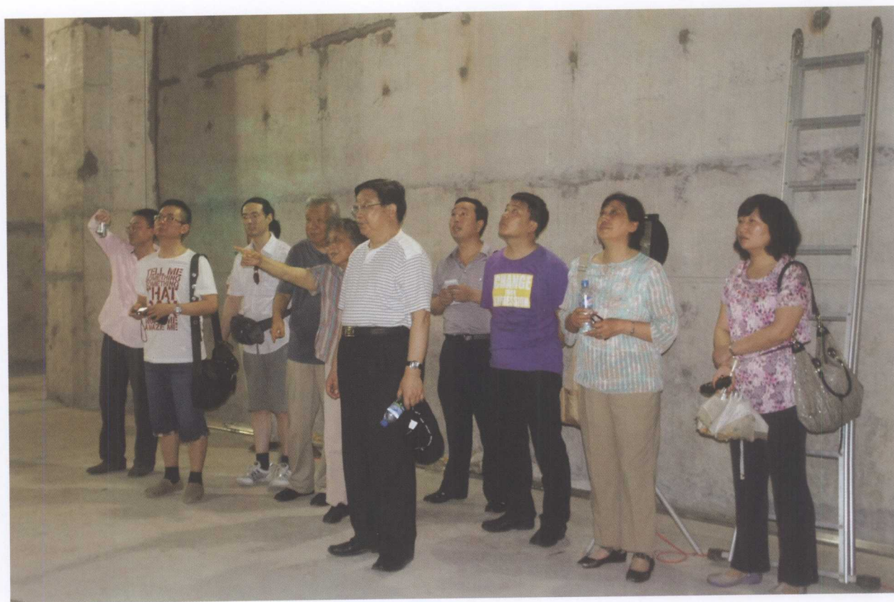
2012年5月，王传祯与三强核力辐射工程技术有限公司部分职工在越南胡志明市辐照装置安装现场
