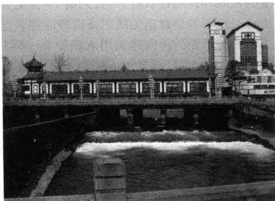
图1-2 都江堰水利工程
