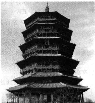
图 1-5 山西应县木塔
