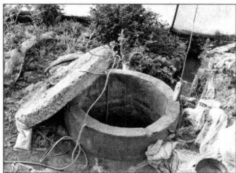
图 27 武威市凉州区高坝镇碌碡村 日光温室装备的蓄水池
