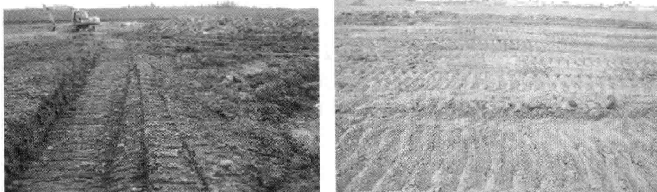
图 1-1 肥沃的表土被机械碾压后形成的车辙
