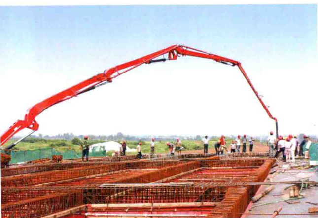
▲ 建设中的 104 国道句容段新坊互通
